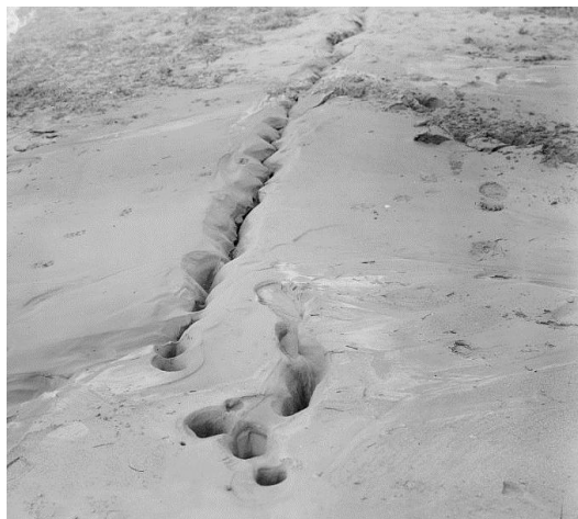
איור 1.1: עקבות בעבוע חול מתוך סדק לאחר רעידת האדמה בים המלח ב-1927. צולם באיזור יריחו על ידי צלמי המושבה האמריקאית בירושלים
