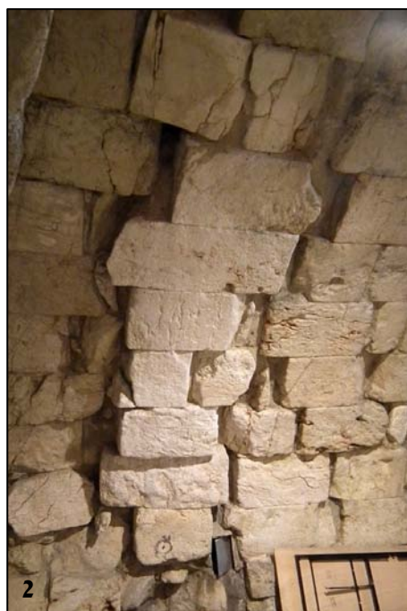
תרשים 1.7: הקמרון המערבי ביותר במערכת הקמרונות של הגשר הגדול. סדקים באבני הבנייה ובניהן, אבנים מרוסקות ומעוכות, דפורמציות קשות. 1. מבט כללי מצפון. 2. שברים, סדקים ודפורמציות בקמרון.
