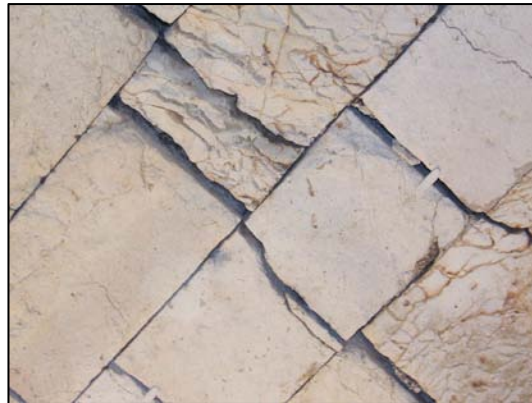
תרשים 5.9: סדיקה של אבני הבנייה בקמרון 5 כתוצאה מריכוזי מאמצים או מאמצי גזירה
