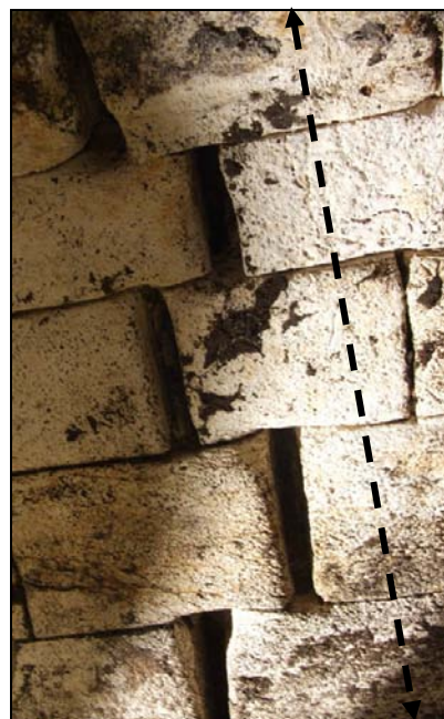
תרשים 1.34: קמרון 6, סדקים בקמרון הנובעים מ"פתיחה" בכיוון צפון-דרום הקו המקווקו – ציר מזרח-מערב (תאריך צילום: 15.6.2008)
